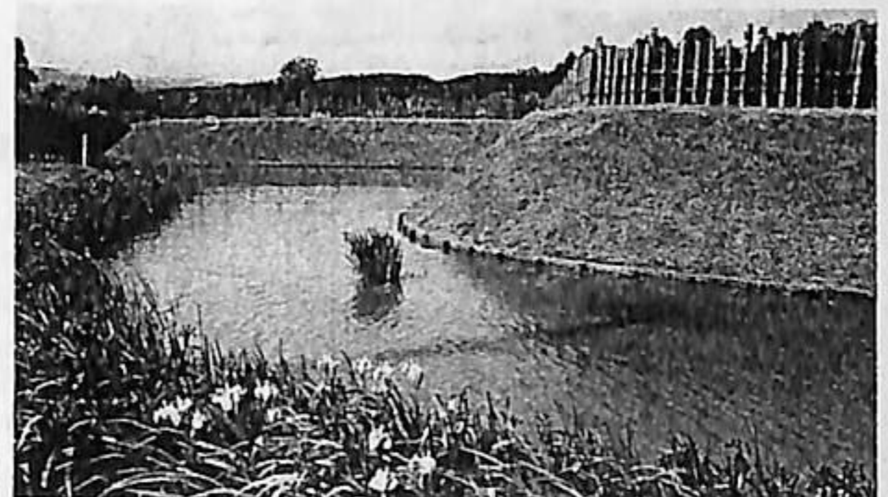
●監物堀と土壘 平成8年に、山麓を巡る総構である監物堀の堀や土壘の一部と番小屋などが復元された。なお、1.5kmに及び監物堀すべてを復元整備する壮大な計画もある。
